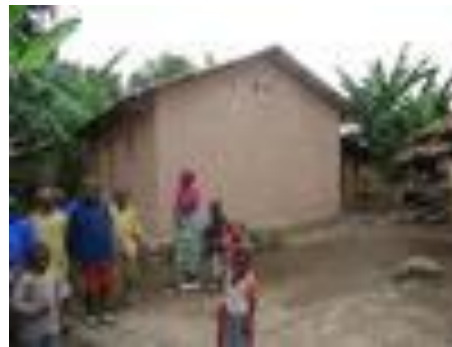
Figuur 5: Het huis na de renovatie
