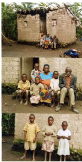
Figuur 6: Het huis voor de renovatie
