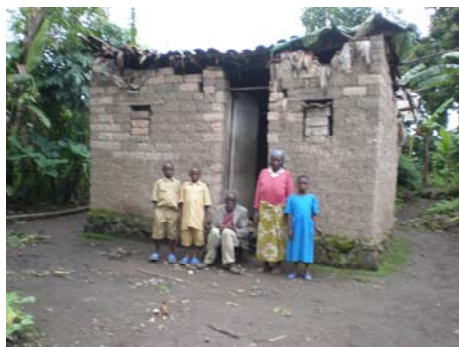
Het huis voor de renovatie
